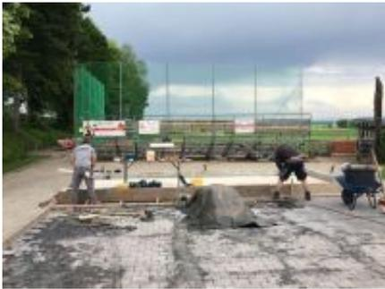
Das Streifenfundament für das provisorische Hütte wird gegossen.
