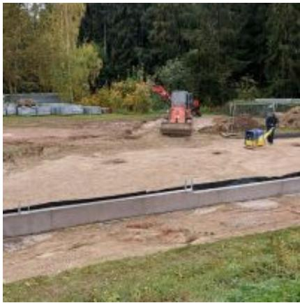
Die Punkt und Streifenfundamente wurden geschalt und anschließend betoniert. Nachdem die Betonschalung entfernt wurde, wurde die entgültige Planie hergestellt, als untere Tragschicht für den späteren Untergrund.
