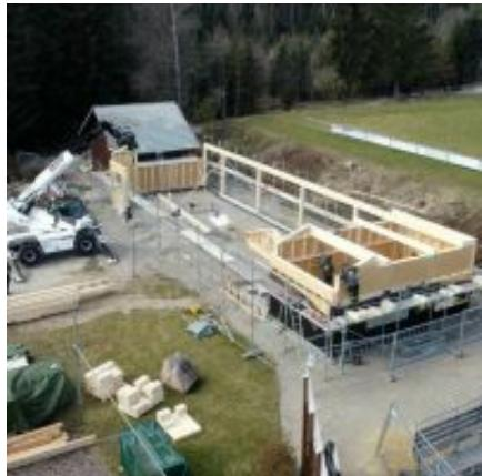
Nach langer Vorarbeit in denen sämtliche Wände vorgefertigt wurden und das ganze Baumaterial auf die Baustelle gebracht wurde, ging es dank dem guten Wetter mit dem Hochbau los. Angefangen mit dem Rückbau des vorhandenen Daches des Kiosk wurden anschließend erste Wände gestellt, Stahlstützen eingespannt und Stahlstützen in die Köcherfundamente eingebracht.
