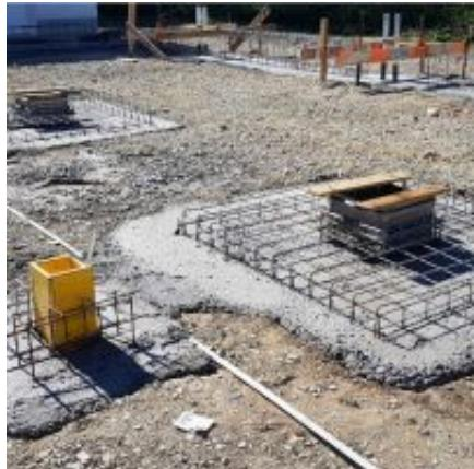
Die Planie war hergestellt, somit wurden die Gräben für die Leer und Abwasserrohre ausgegraben. Anschließend wurden diese mit Schotter angefüllt und die Rohre, nach Plan, eingezogen. Daraufhin wurden die Punkt und Streifenfundamente ausgehoben und Mithilfe einer Eisenbieger Firma die Armierungen gebogen und per Teleskoplader eingesetzt.
