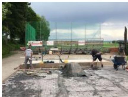
Das Streifenfundament für das provisorische Hüttle wird gegossen.
